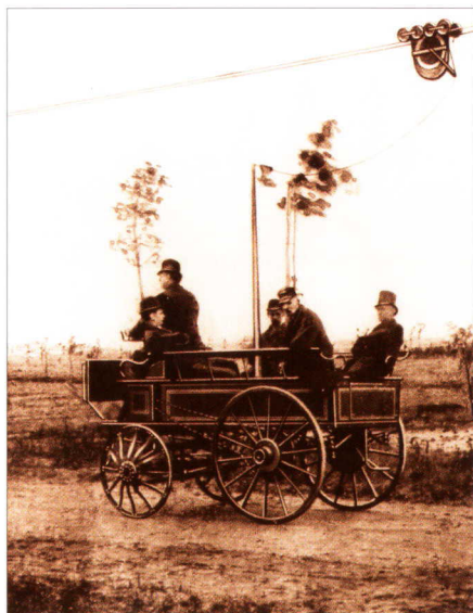
▲ Erster von Siemens & Halske gebauter Fahrdrachtbus – Elektromote – auf der Versuchsstrecke Berlin-Halensee 1882.
