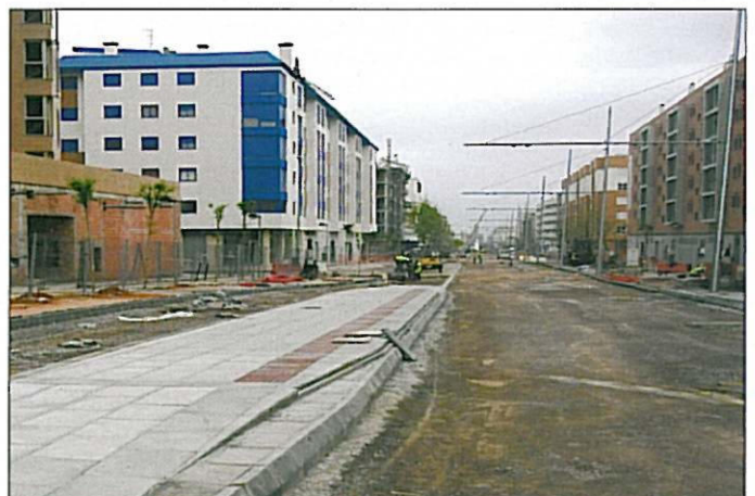
Trassen- und Haltestellenbau in Castellón. Bemerkenswert sind die stark geneigten Fahrleitungsmasten.
