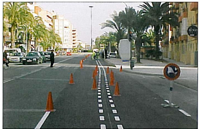
Arbeiten zur Trassenmarkierung der – ebenso wie in Rouen – rötlich eingefärbten Busspur und Aufbringung der Führungslinien in Castellón
