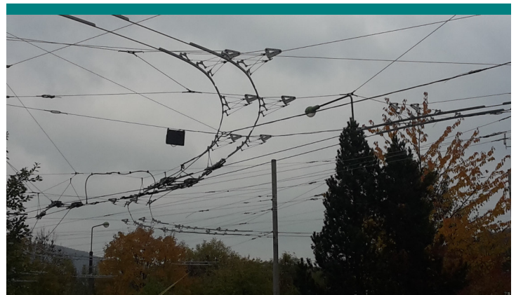
Abbildung 6: Der Aufwand bei Verzweigungen der Oberleitung verursacht die größten Kosten beim Obusbetrieb.
