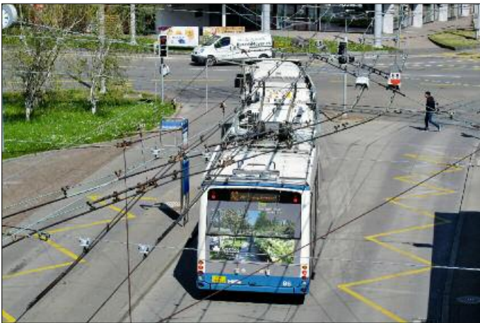
7. Bucheggplatz, Fahrleitungsanlagen der Trolleybuslinien 32 und 72 und der Tramlinie 15; Blick auf das Dach eines DGT
