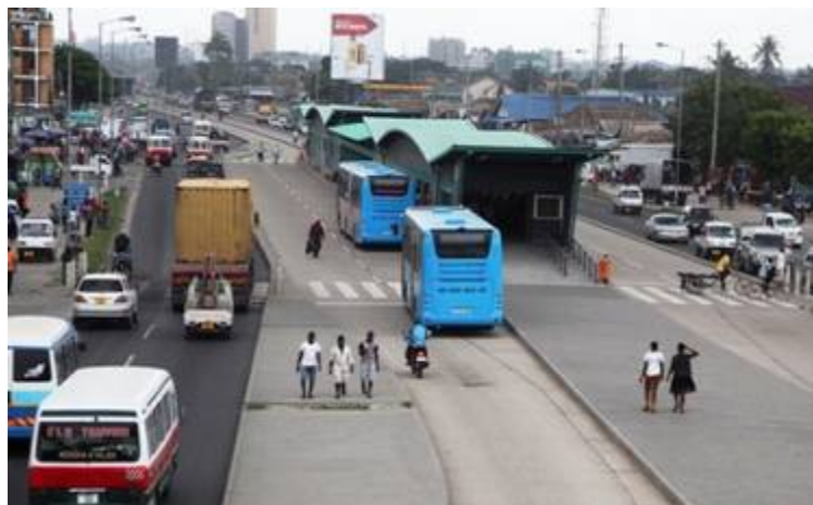
Station BRT avec une seule voie de circulation par sens entre les stations et 2 voies en station
