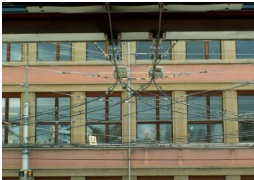
Weichenanzeigen: Liegen gut im Gesichtsfeld des Chauffeurs.
