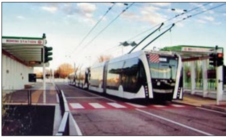
23. Zweispurige Haltestelle Rimini Station mit ebenerdigen Fußgängerübergang, Signalanlagen und drei Van-Hool-Fahrzeugen
